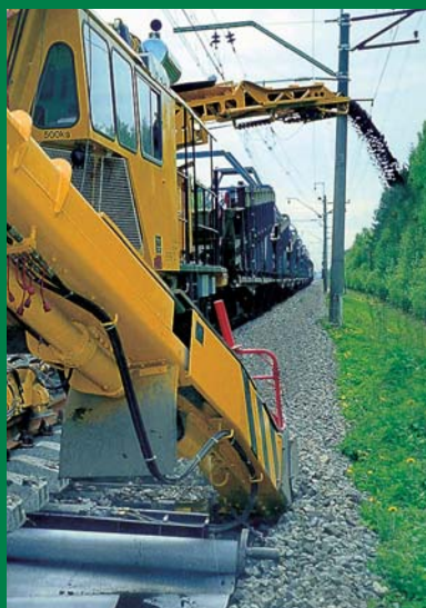
Renovering av järnvägsspår mellan Moskva och St. Petersburg (Ryssland)
